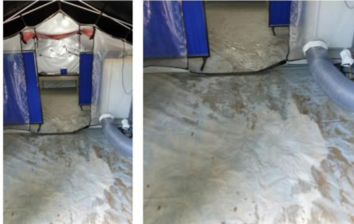
Descripción. Condición interna del área de microbiología, exposición a nuevas inundaciones y superficies resbaladizas producto del lodo.
