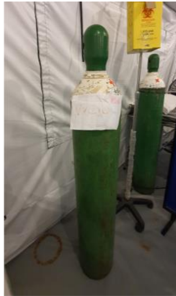
Descripción. Tanque de oxígeno sin soporte y colocado en suelo inestable.
