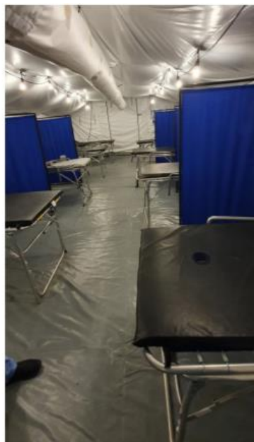
Descripción. Entrada al área de estabilización donde la superficie del suelo es irregular y poco firme, producto de la mala compactación del terreno.
