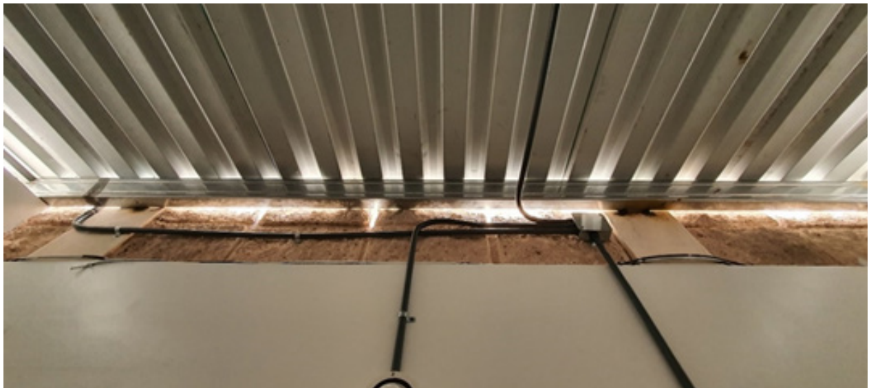
Fotografía del baño construido en la sala de usos múltiples donde se observa ranura en el techo.
