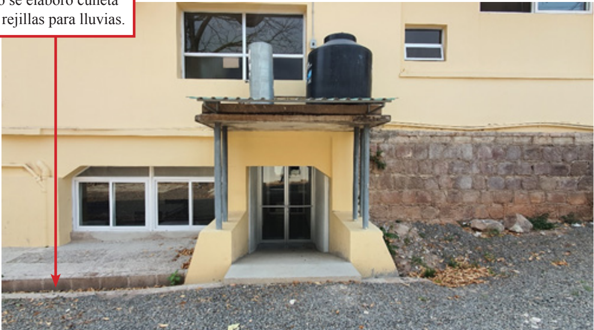
Sala de observación n.º 1, ubicada en el edificio n.º 7.
