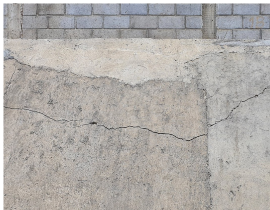
Descripción: fisuras en muro de talud con revestimiento de concreto.
