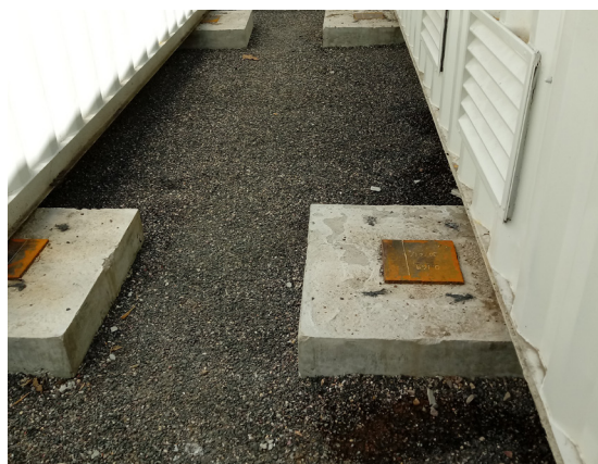
Descripción: dados de concreto con placas, algunos contenedores no se apoyan en las placas, sino que directamente en el concreto.
