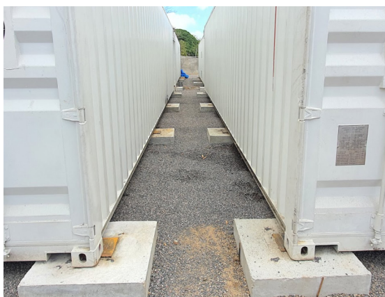
Descripción: dados de concreto con placas, algunos contenedores no se apoyan en las placas, sino que directamente en el concreto.
