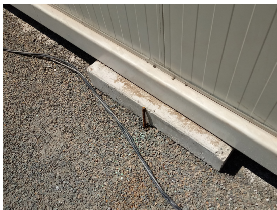
Descripción: dados de concreto sin placas metálicas y en algunos al borde el contacto de los contenedores en su apoyo.
