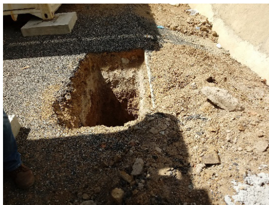
Descripción: doble tratamiento asfáltico y base de suelo cemento en plantel.
