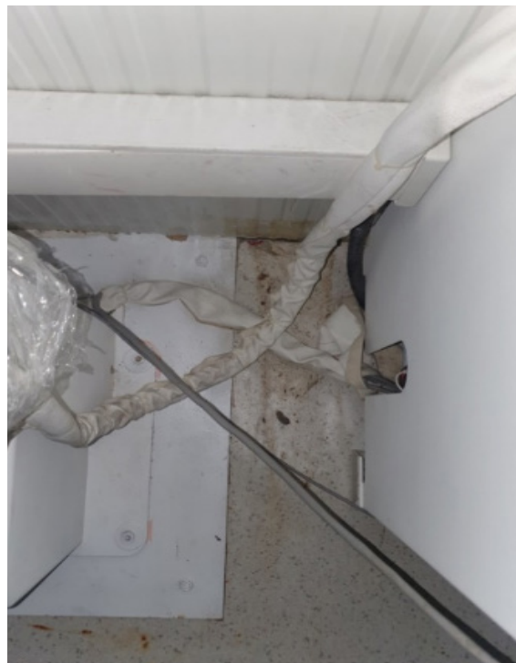
Descripción: conexiones del generador a tubo de rayos.
