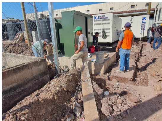
Descripción: instalaciones para las plantas eléctricas del hospital móvil.
