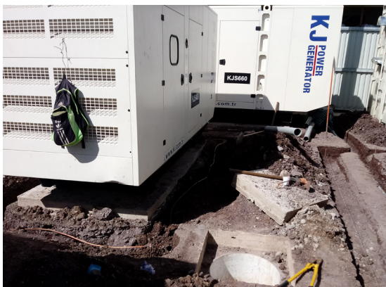
Descripción: instalaciones para las plantas eléctricas del hospital móvil.
