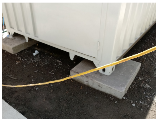
Descripción: dados de concreto sin placas metálicas y en algunos al borde el contacto de los contenedores en su apoyo.
