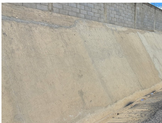
Descripción: fisuras en muro de talud con revestimiento de concreto.
