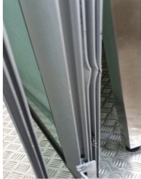
Descripción: puertas corredizas con daños en su estructura y vidrio.
