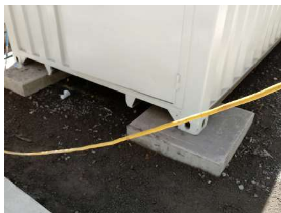
Descripción: dados de concreto sin placas metálicas y en algunos al borde el contacto de los contenedores en su apoyo.
