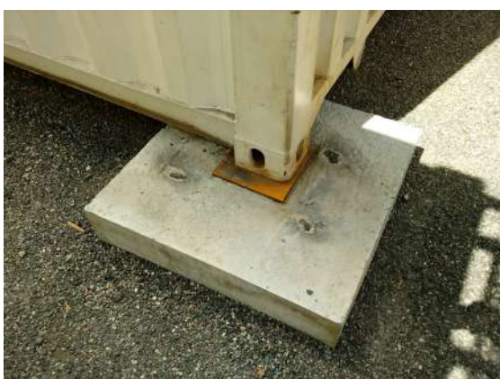
Descripción: contenedores colocados en dados de concreto con placa que son los apoyos de estos. Se debió pintar con anticorrosivo dichas placas para una mejor conservación de estas.
