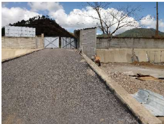
Descripción: rampa de acceso y cuneta para drenaje pluvial.
