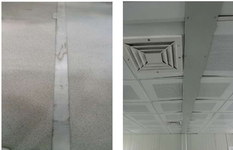
Descripción: estructura metálica de la junta interior de los contenedores.
