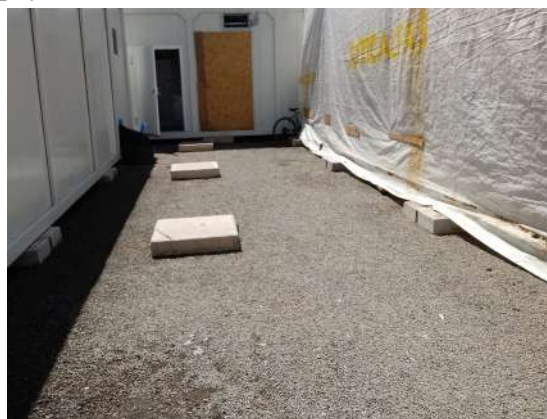
Descripción: dados de concreto sin placas metálicas y en algunos al borde el contacto de los contenedores en su apoyo.
