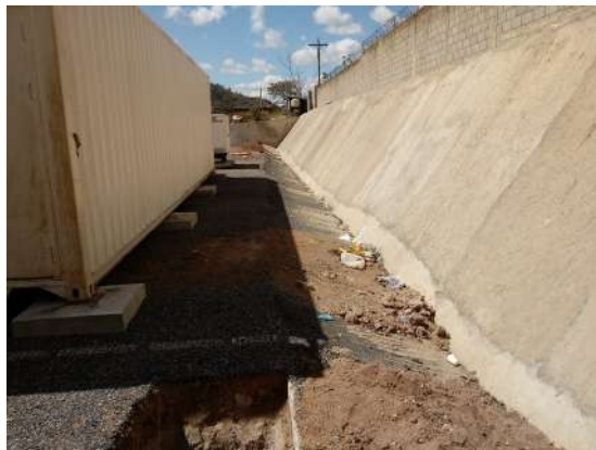
Descripción: rampa de acceso y cuneta para drenaje pluvial.
