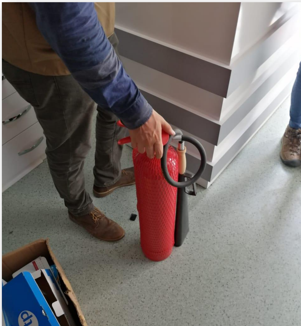
Evidencia n.º 14. Extintores de los hospitales móviles.
