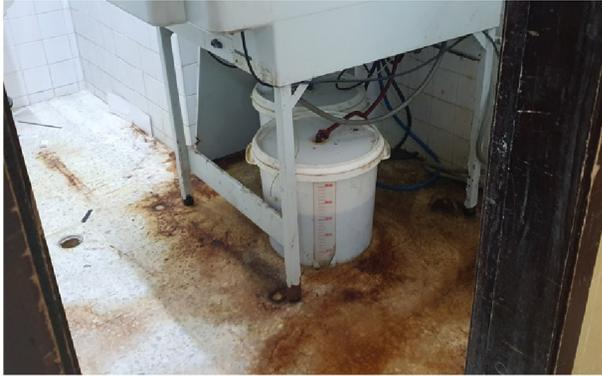
Improvisación en instalación de drenaje de aguas servidas.
