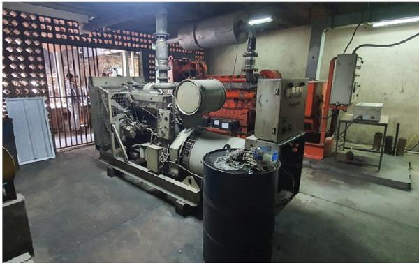
Planta generadora de corriente alterna marca *cummins* en mal estado y obsoleta.
