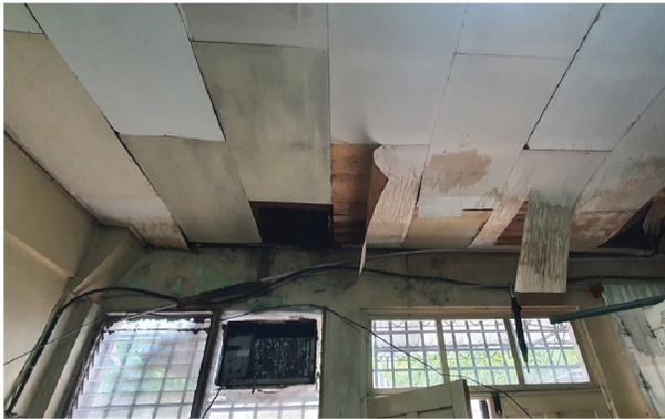
Daños severos en techos, debido a la filtración permanente de agua.
