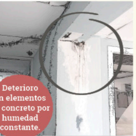
Se identificó trabajos de remodelación.
